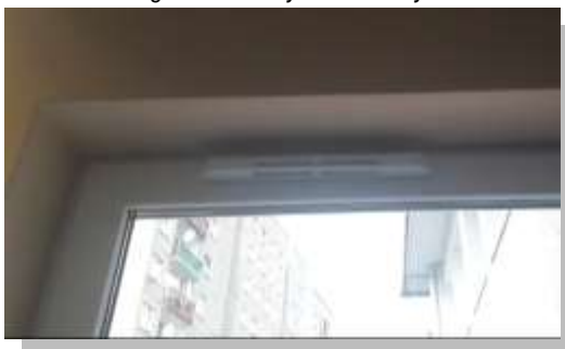
Ryc.1. Nawiewnik higrosterowalny montowany na ramie okiennej.
